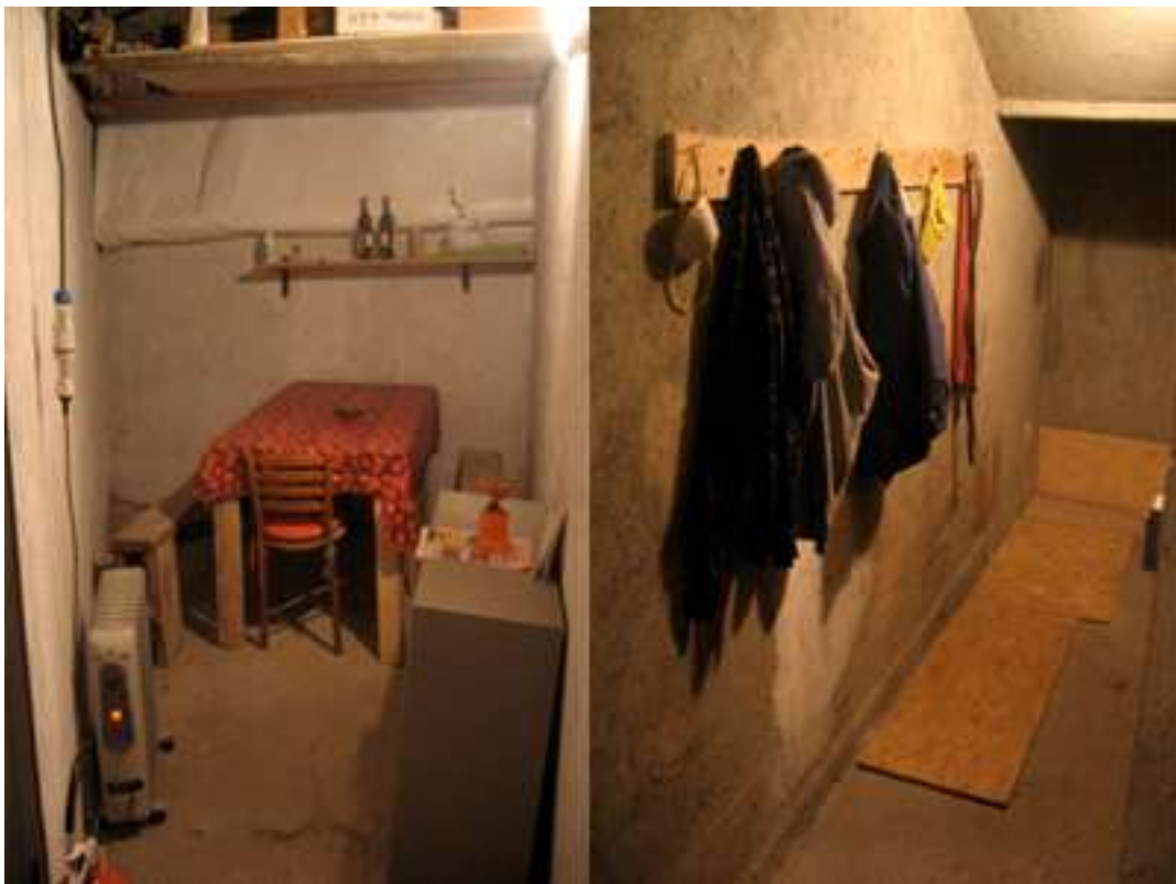
↓ L'impianto elettrico di cantiere. ↓
